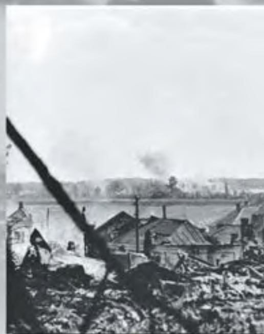
Разрушения в Житомире.
