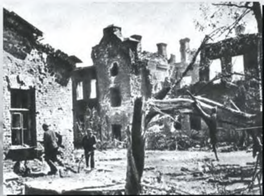
Разрушенный г. Брест
